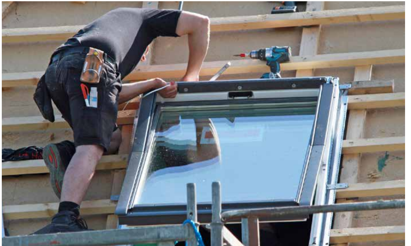
Massnahmen, die zur Verminderung von Energieverlusten der Gebäudehülle dienen, können gemäss eidgenössischer Verordnung steuerlich zum Abzug gebracht werden. BILD KARA/FOTOLIA
